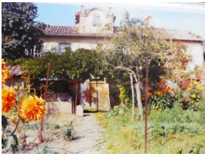
Le presbytère et son jardin avant leur démolition
