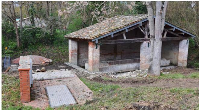
Cet ensemble est alimenté par l'eau de plusieurs sources collectées et conservées dans deux bassins cylindriques de captage, d'un diamètre de 3.56 m, ces bassins sont remarquables car construits en briquettes roses. L'eau des sources alimente donc la fontaine, l'abreuvoir, puis les bacs du lavoir ; les eaux de lavage se déversent ensuite dans la Chauge, avant de s'y perdre...
