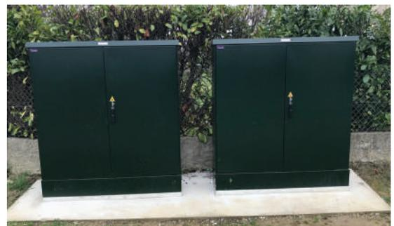
Les armoires de rue (PMZ = Point de Mutualisation de Zone) ont été installés au deuxième semestre; il y en a 4 pour la commune (2 au chemin du Moulin, 1 place du Vidalet et 1 Chemin des Cigareaux). Les travaux se poursuivront en 2019 avec la construction des tronçons optiques principaux jusqu'aux armoires. Le déploiement de la fibre se déroule sans faire de tranchées dans la chaussée, sans casser les trottoirs. Il se fait en suivant le trajet actuel des fils de téléphone en cuivre.
